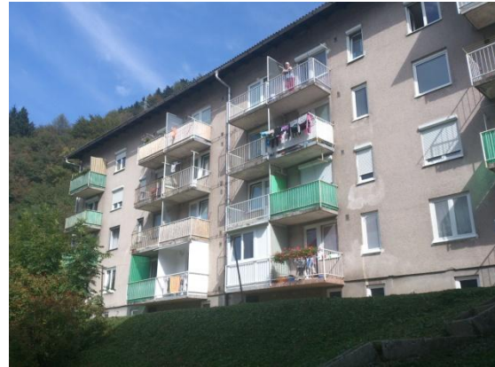
Slika 3: Pogled na stavbo iz JV strani
