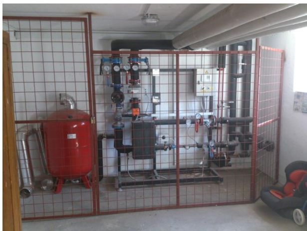
Slika 4: Toplotna postaja v kleti stavbe
