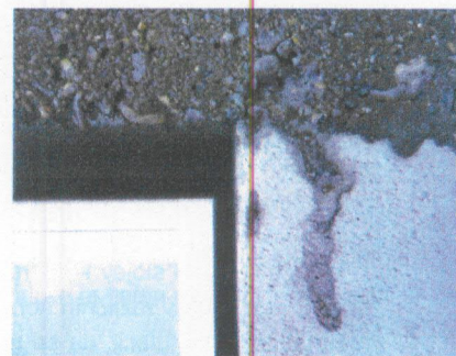
Pri sodobni vgradnji po sistemu tesnjenja v treh ravneh se lahko uporabljajo tudi posebni penasti trakovi, ki združujejo več lastnosti; po vgradnji hitro ekspandirajo in zapolnijo celotno rego.
